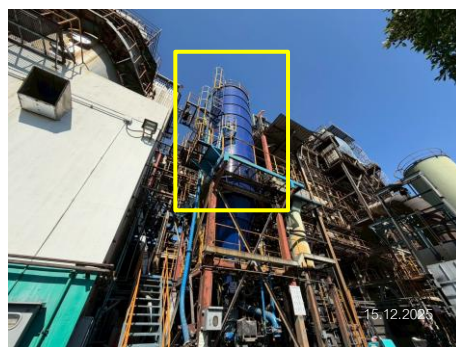
ภาพที่ 2-12 Activated Carbon Injection และ Dry Scrubber (Lime Silo)
