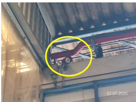
ภาพที่ 2-52 ระบบตรวจจับการรั่วไหลของก๊าซ
