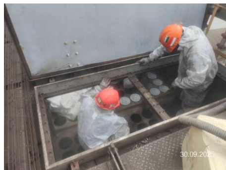
ภาพที่ 2-16 การเปลี่ยนถุงกรอง Bag filter unit
