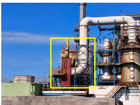
ภาพที่ 2-13 Activated Carbon Adsorption Tower
