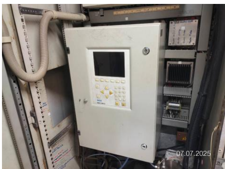
ภาพที่ 2-17 ระบบ CEMS ของโครงการ
